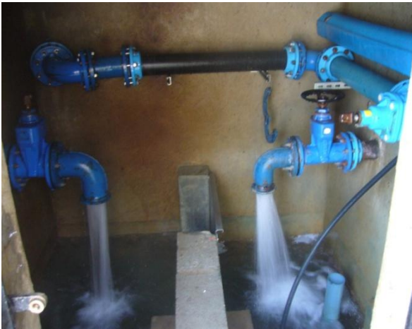
La chambre de répartition à gauche : source des Cerdailleurs à droite : source de la Duys
