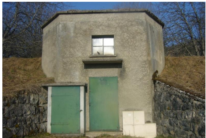
Le réservoir de Montagny
